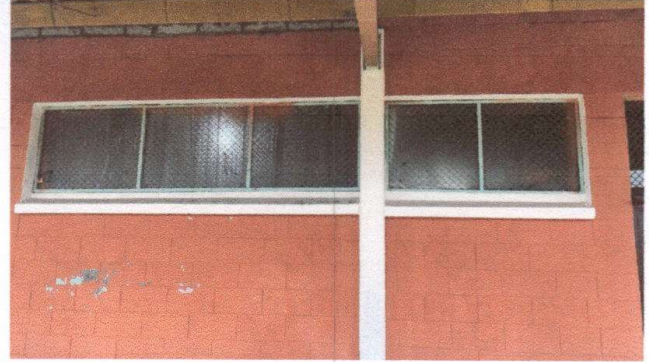
foto 8: Fabricación e instalación de Balcon de metal en ventana (módulo de dirección)
