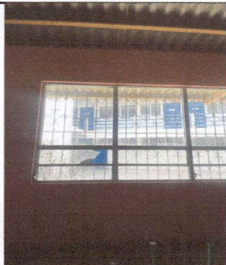
Foto1: Sustrucción de estructura de aluminio de ventana (modulo de cocina)
