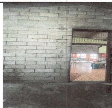
Foto 4: Pintura de paredes interior (modulo de cocina)
