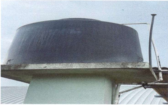
FOTO 7 : Sustitución de depósito de agua de 1700 litros (modulo de baño)
