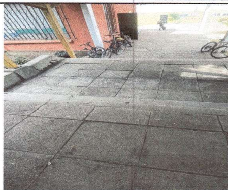
foto 2: Sustrucción de piso de torta de concreto
